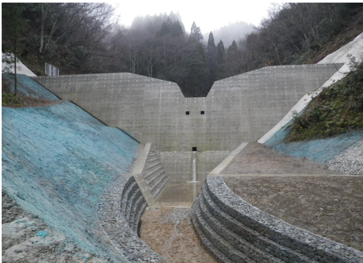
湯ノ子川 砂防堰堤工事
