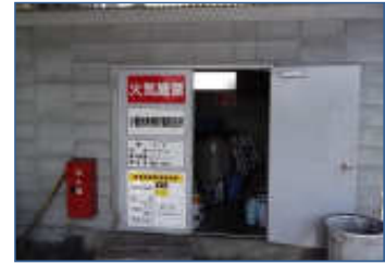
少量危険物倉庫
