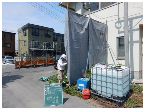
民家周りへは固定の防音シートを設置
