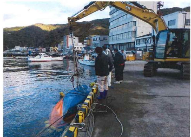
0.45m 3 級クレーン機能尾付きバックホウにより吊り上げ
