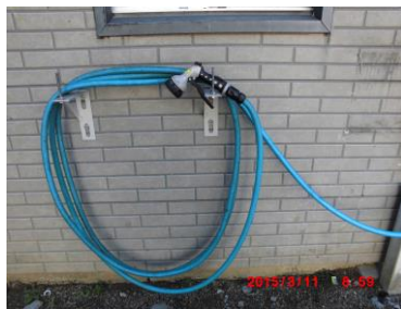
ホースガン取り付け（節水） （平成27年3月）
