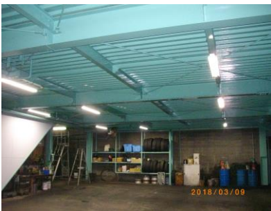
LED照明に交換(1階 車庫) (平成30年1月)
