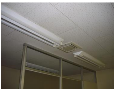
LED照明に交換(事務所 入口) (平成26年12月)
