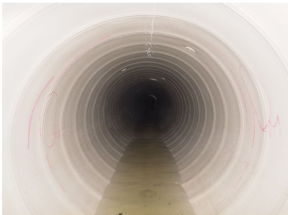
【下水道長寿命化工事】
