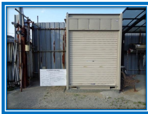
専用シャッター付倉庫 (特別管理産業廃棄物)
