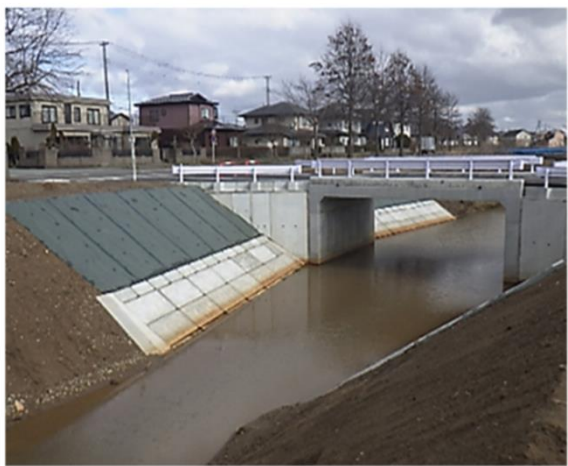
仁井田浄水場工事用仮設橋等整備工事
