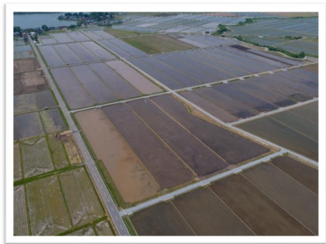
秋田市金足 農地集積加速化基盤整備工事 完成写真
