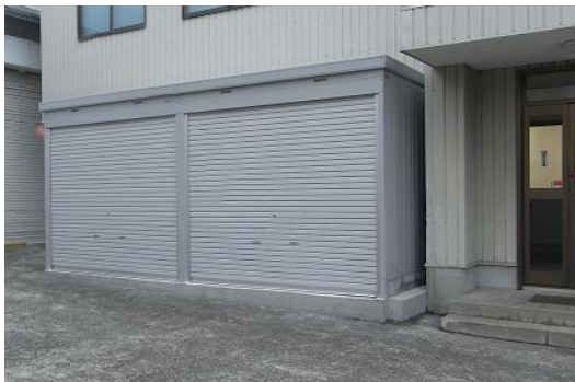
廃プラ保管庫の設置
