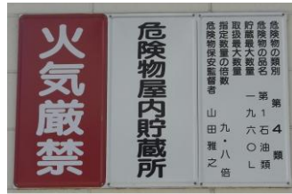
危険物屋内貯蔵所
