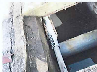
水漏れ箇所修理の様子
