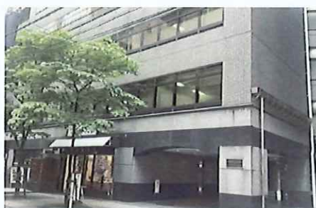
移転先の東京営業所ビル外観
