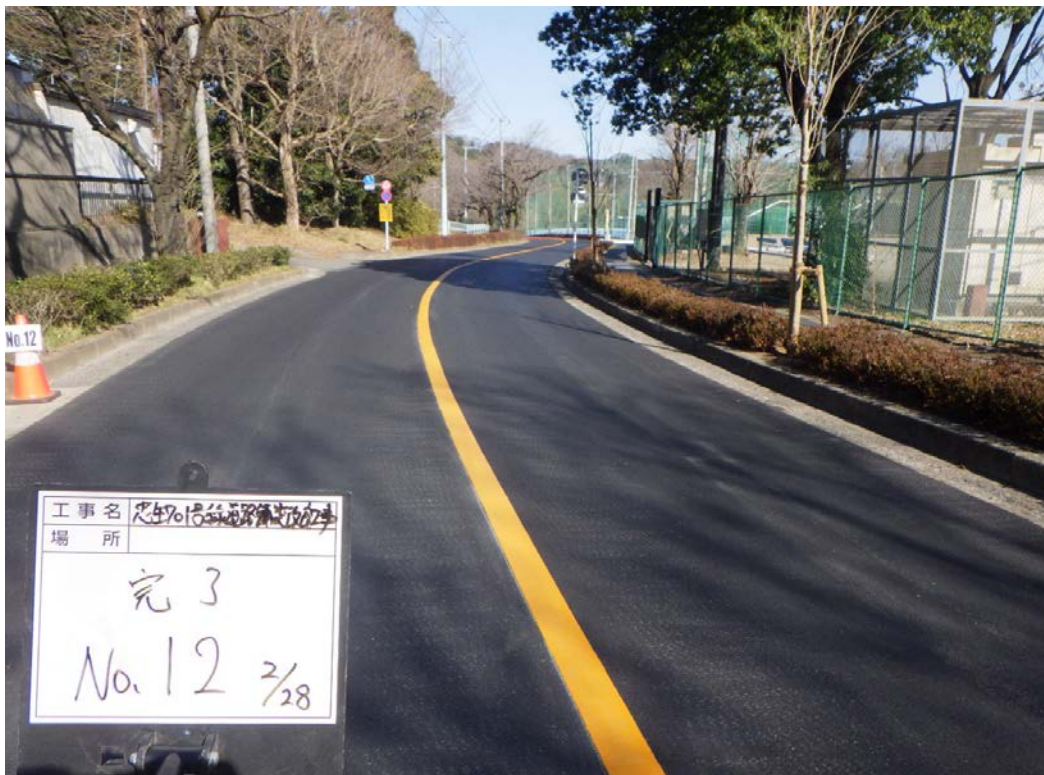
忠生701号線道路舗装改良工事
