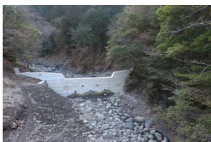
谷止工【木製存置型枠施工】
