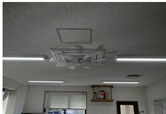
・室内機 交換後
