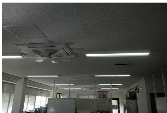
・室内機 交換後
