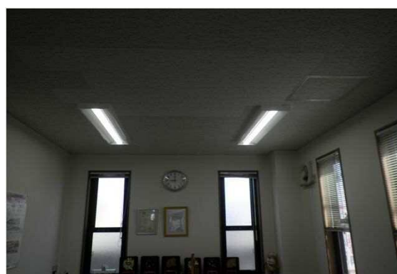
・室内機 撤去後
