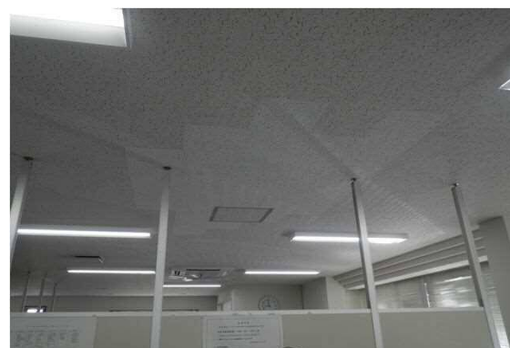
・室内機 撤去後
