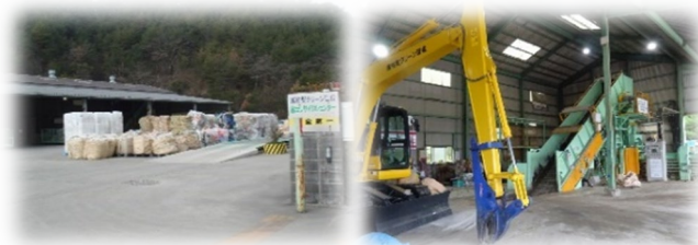
富士リサイクルセンター 敷地面積：9,170㎡ 佐賀県佐賀市富士町大字上熊川716-3
