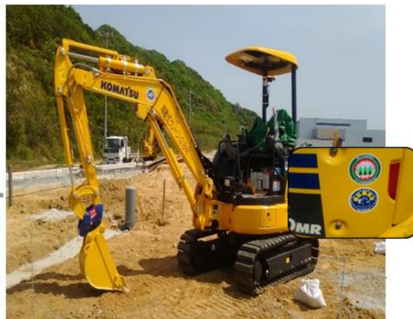
<環境配慮の施工> 3次基準値排出ガス対策型・超低騒音型バックホウ
