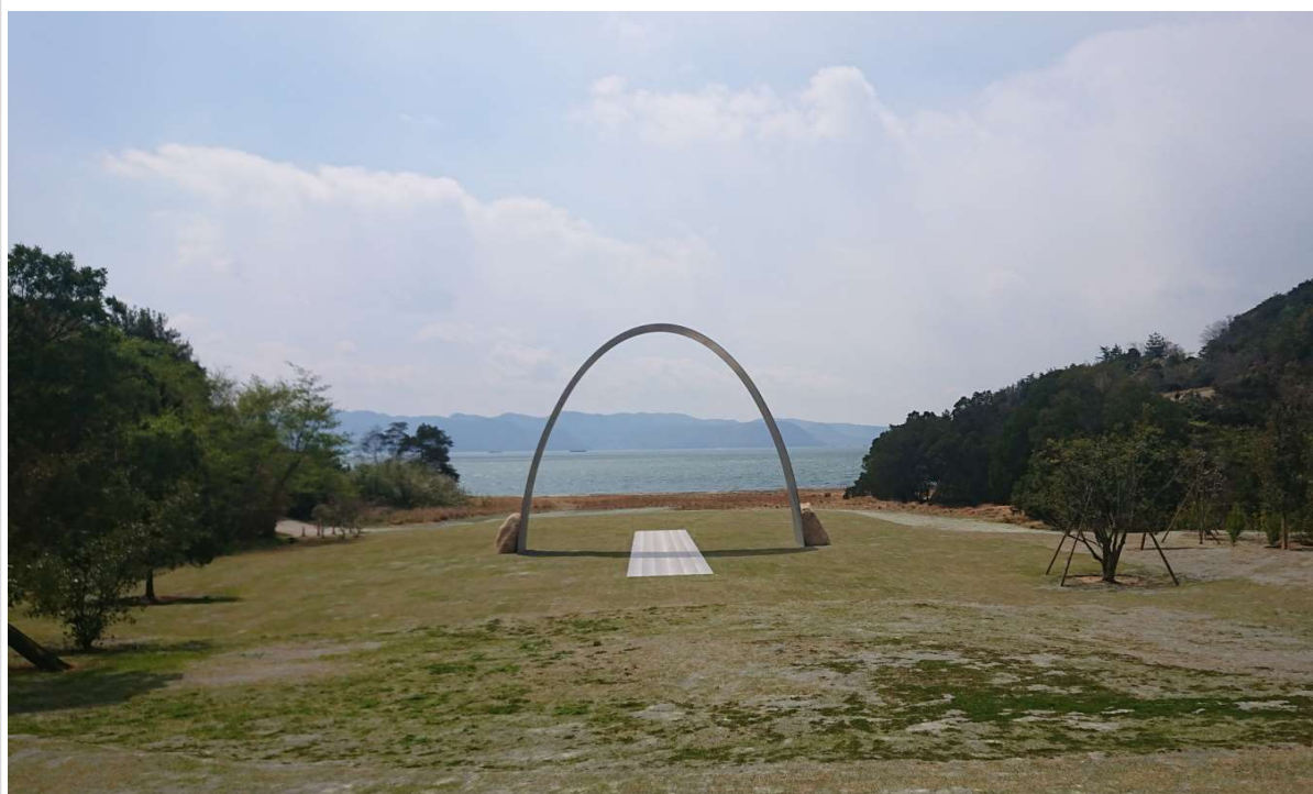
写真:「無限門」(BenesseArt) 基礎工事・植栽工事当社請負
