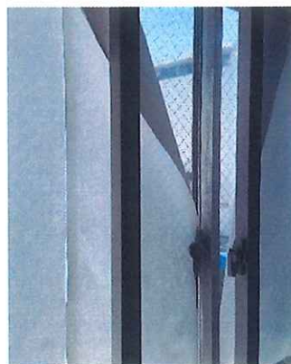
二重窓に交換
