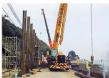
災害復旧工事
