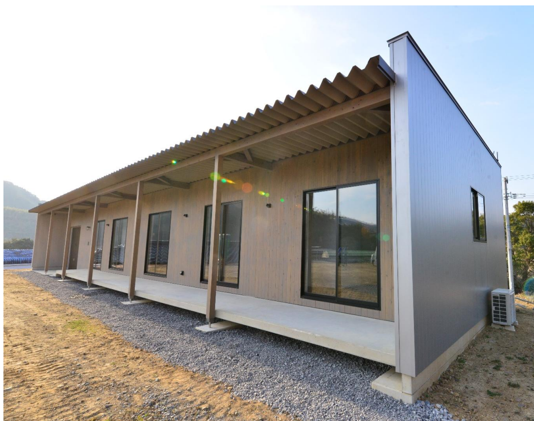
小高い丘の上にある杉板壁の家 Y様邸 施工
