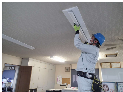
蛍光管をLEDへ交換
