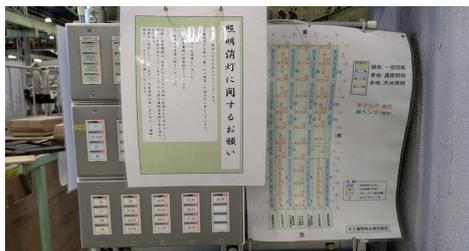
電灯の区域別個別SW化により、不要な区域で消灯を行い、電力使用量の削減しています
