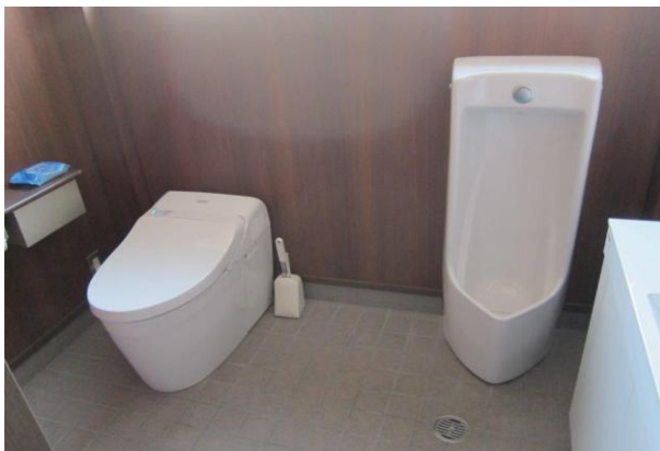
節水式トイレに更新
