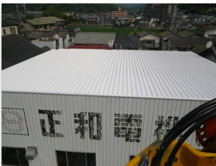
屋根と室外機に遮熱塗料を塗装。
