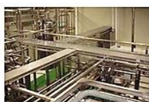
プラント設備施工例①
