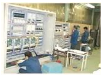
制御盤 組立風景
