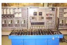
制御盤製作風景
