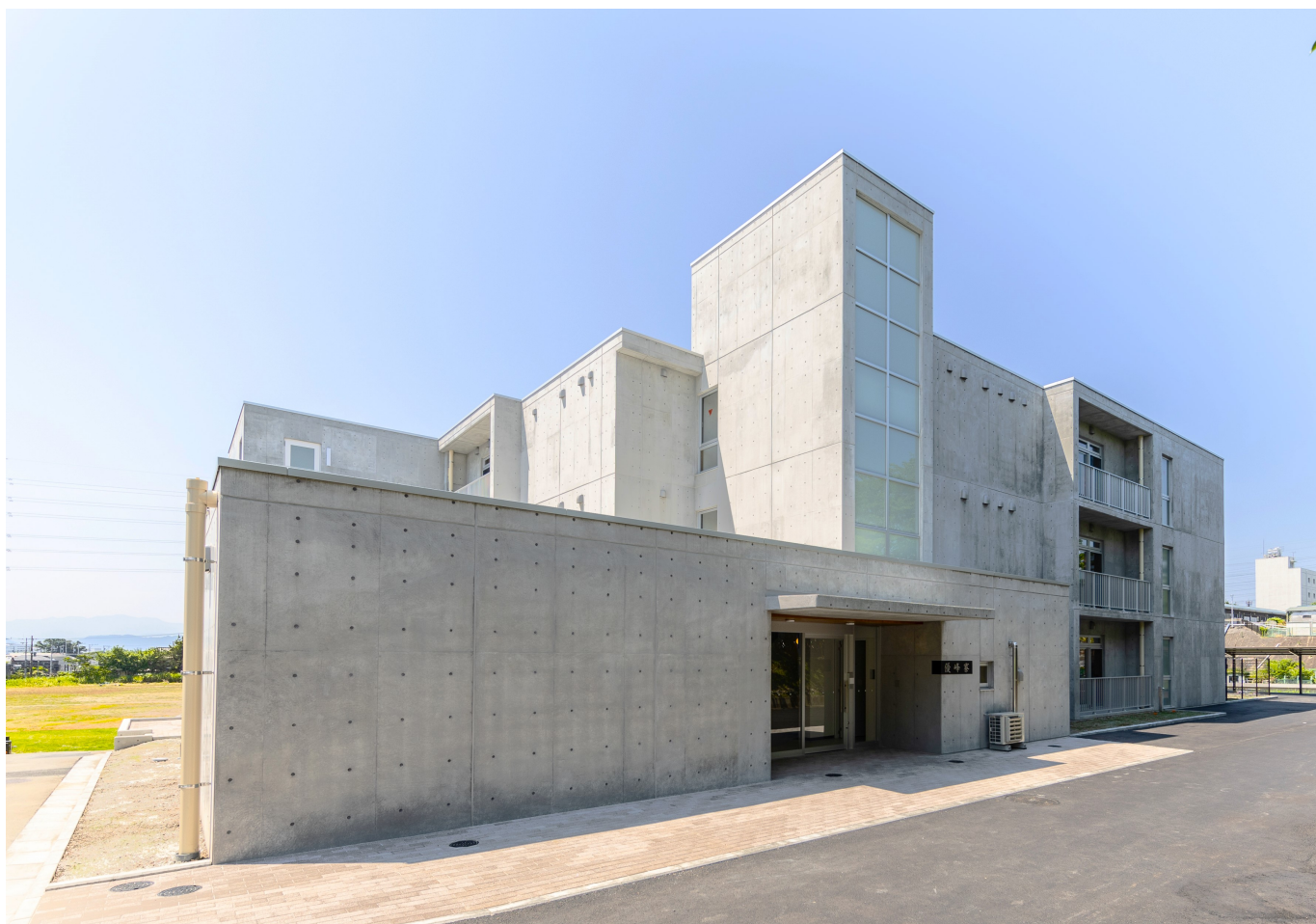
沼津工業高専 優峰寮新営工事（2024年6月28日完成）
