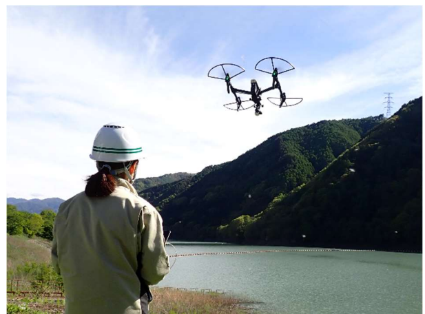
UAV（ドローン）による着工前の確認
