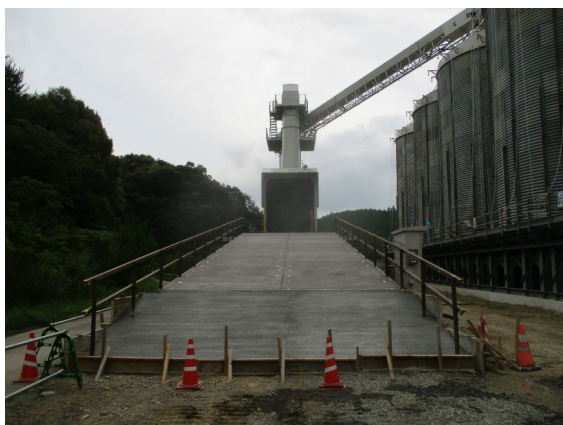
春遠ダム 仮設工事(プラント基礎工事)
