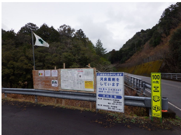
工事名称:弘見川 河川改修工事 工事期間:2023年11月17日 ~2024年 3月25日 工事場所:高知県幡多郡大月町添ノ川
