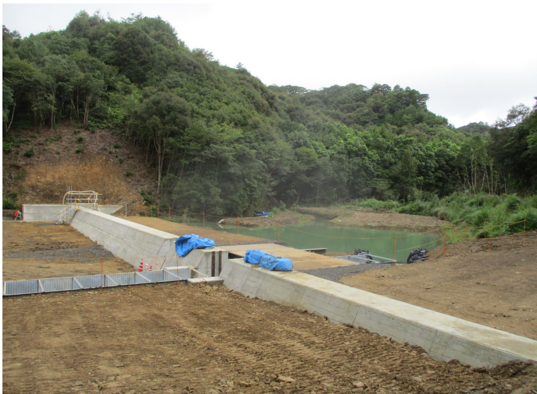
春遠ダム(春遠第1ダム)本体建設工事 作業風景 仮設工事(上流仮締切工) 令和5年9月頃
