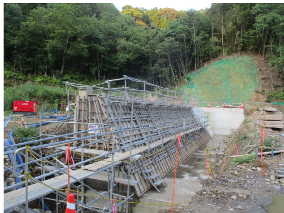
春遠ダム 仮設工事(上流仮締切)
