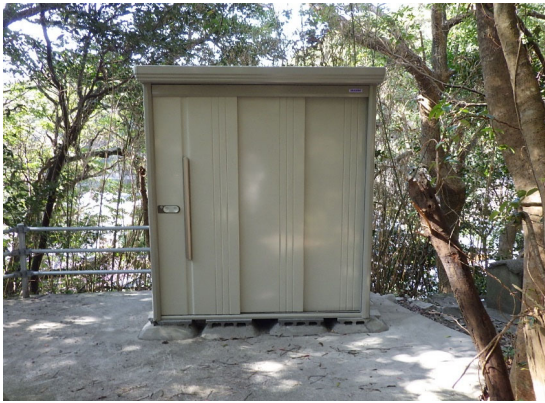
備蓄倉庫設置
