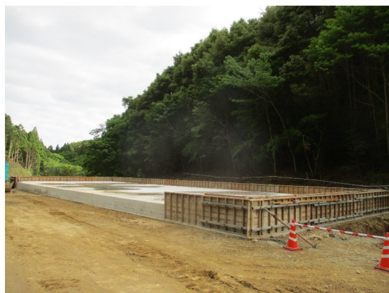
春遠ダム 仮設工事(濁水処理設備基礎工事)
