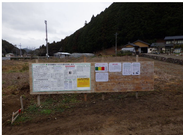
工事名称:浦宗川 砂防メンテナンス工事 工事期間:2023年12月27日 ~2024年 5月31日 工事場所:高知県幡多郡大月町姫ノ井
