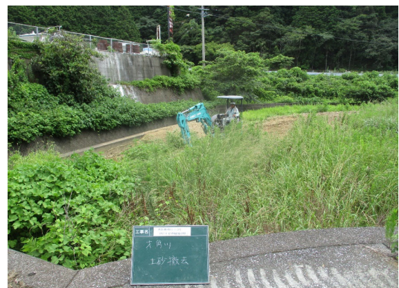
才角川 堆積土撤去
