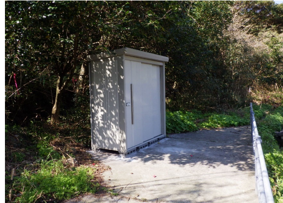
備蓄倉庫設置
