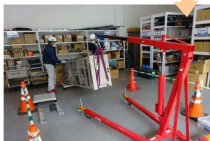
吊り上げ装置使用時の様子
