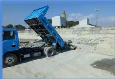
コンクリートの リサイクル
