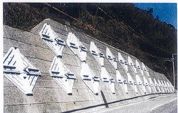
⑫県道日ノ御子土佐山田線防災・安全交付金工事 高知県中央東土木事務所 アンカー工 23本、330m
