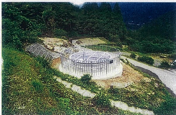
⑪西川地すべり防止工事 高知県中央東土木事務所 集水井 1基、集排水ボーリング 計13本
