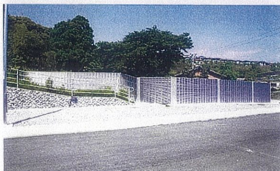
⑬県道高知東インター線社会資本整備総合交付金工事 高知県中央東土木事務所 遮音壁（23m）、遮音パネル（9m）
