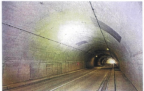
⑩国道321号 トンネル修繕工事 高知県幡多土木事務所 土佐清水事務所 裏込注入工 108㎡
