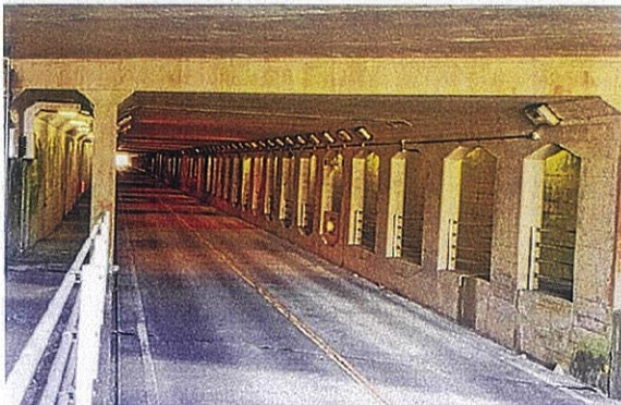
⑨県道前浜植野線道路附属物修繕（高知空港地下道）工事 高知県中央東土木事務所 新面修復工、剥落対策工
