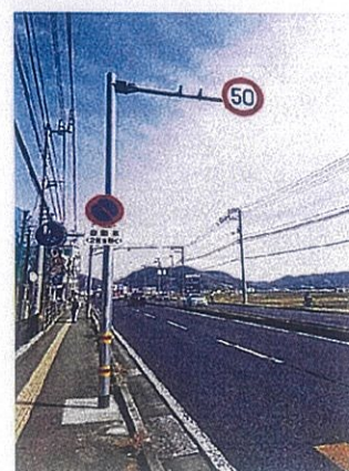
⑭29規制第32号 道路標識設置工事 高知県警察本部 警察部 装備施設課 道路標識等43か所
