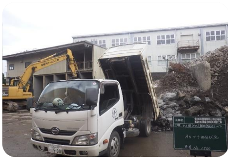
過積載防止対策(積載状況確認)
