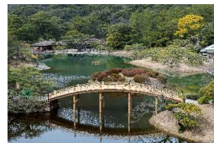
栗林公園偃月橋改修工事
