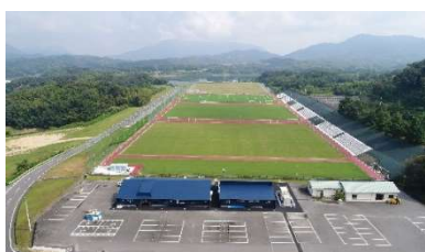
「レグザム・カマタマーレ讃岐 クラブハウス」竣工
