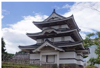
高松城北之丸月見櫓改修工事
