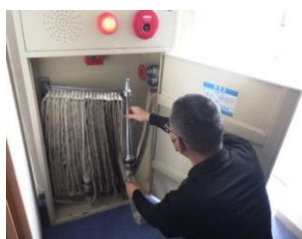
消防設備の点検
