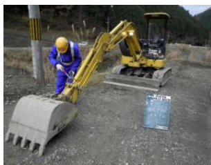
重機の使用前点検・整備
