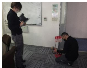
消火器の使用期限等確認
