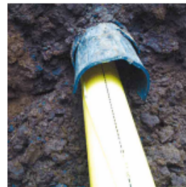
■トリックトレンチレス工法■
