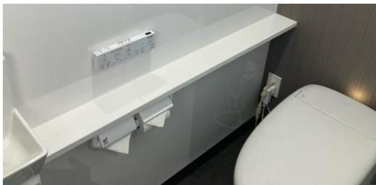
トイレの2度流しをしないために擬音装置を設置し、節水型トイレにリフォームしました。
