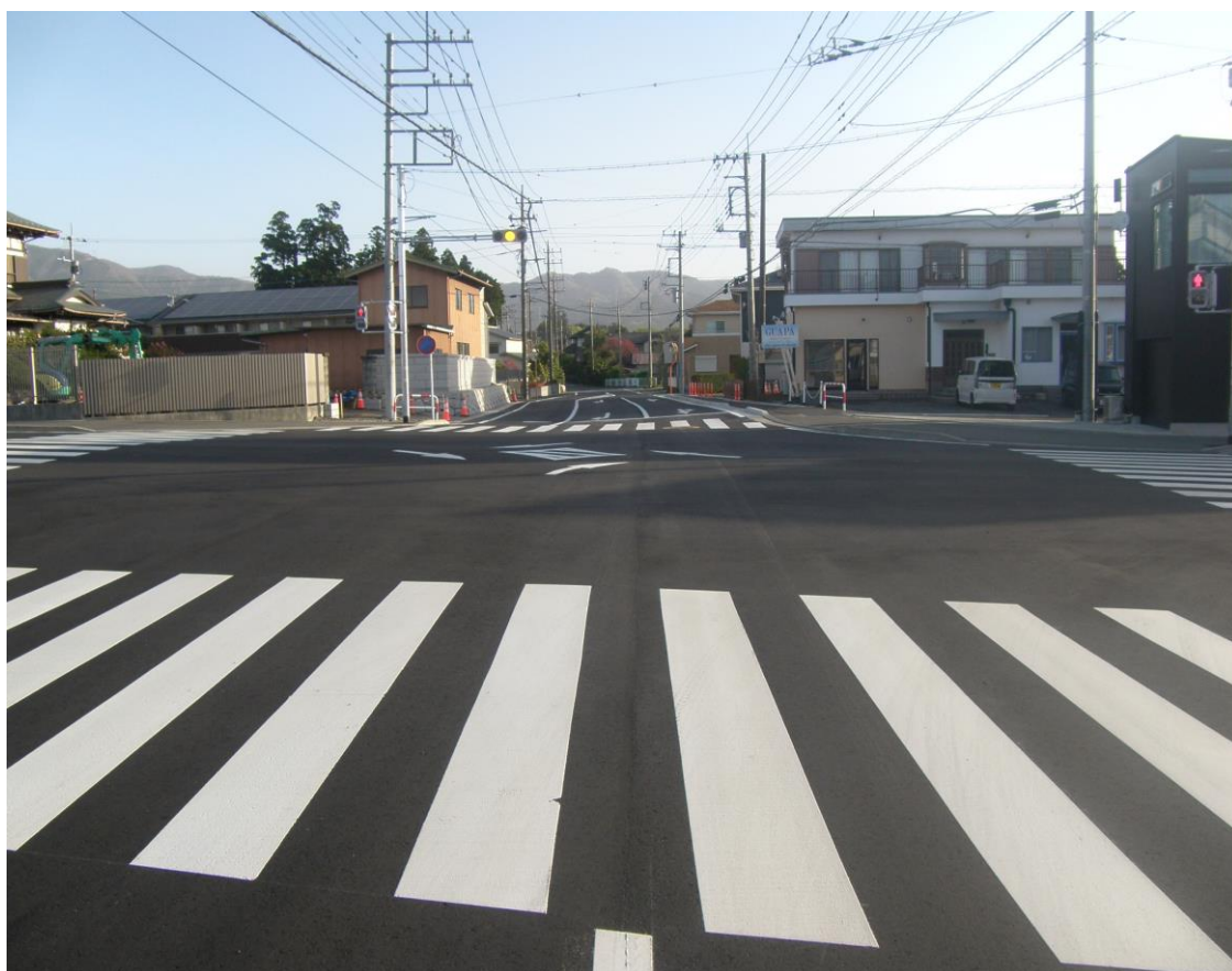
令和5年度 町道一色中日向線交差点改良舗装工事
