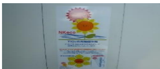
光媒性作用パネルでの仮囲い
