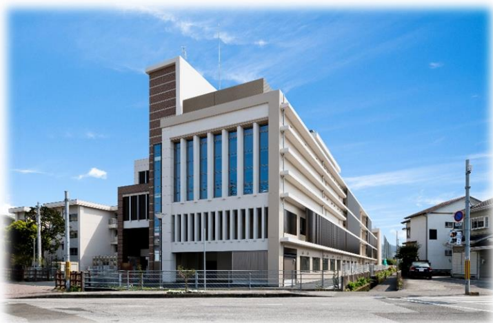
新中高一貫教育校校舎新築建築主体工事 (高知国際中・高等学校)
