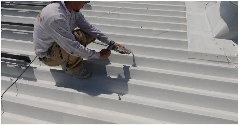
※倉庫屋根の太陽光パネル取付 金具の補修
