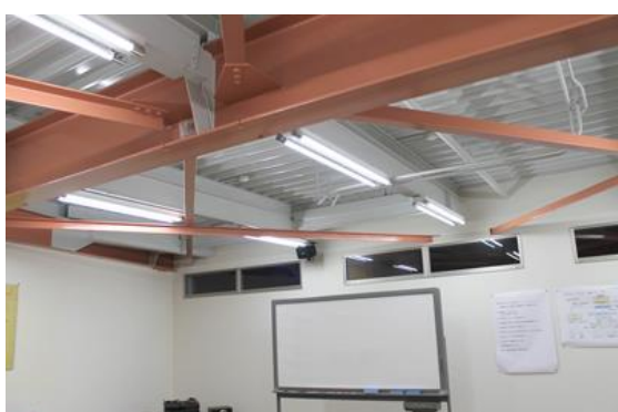
1F会議室LED設置
