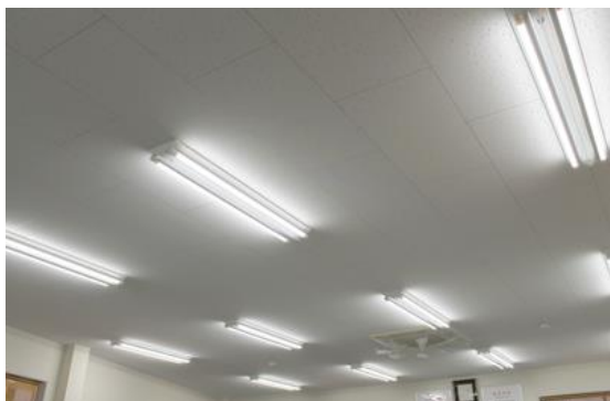
3F事務室にLED設置 ※他、事務所棟内全部の蛍光灯をLEDに変更
