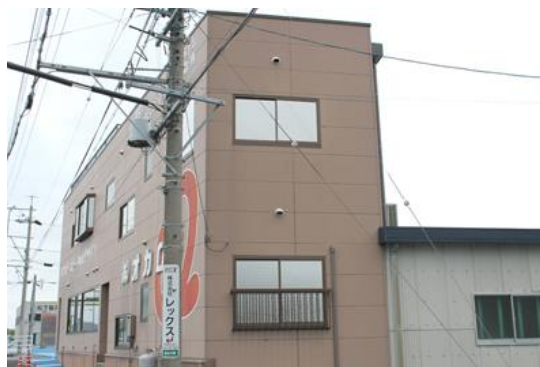
サーバールーム・休憩室の窓ガラスにフィルム施工 ※冷房効率の向上のため
