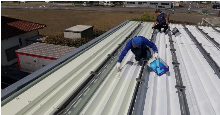
※倉庫屋根を遮熱用塗料による 塗替え
