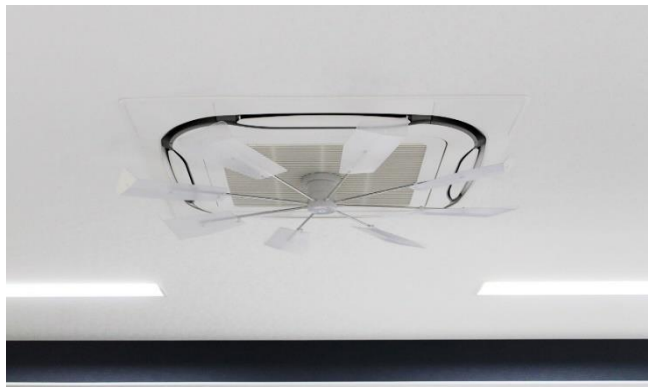
※冷暖房の温度むらを攪拌、空調効率の向上のため新事務所にハイブリッドファンを増設
