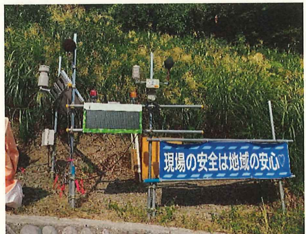
現場内：気温湿度雨量（熱中症）及び 騒音の表示 作業員への注意喚起
