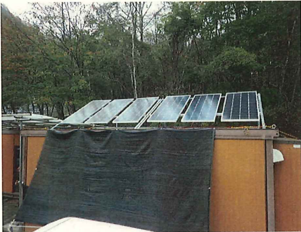
現場事務所に太陽光パネル設置
