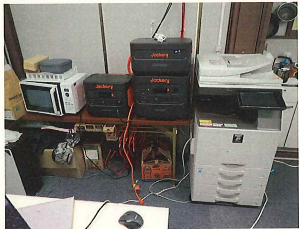
太陽光パネルにより発電した電気を蓄電 現場事務所にて使用
