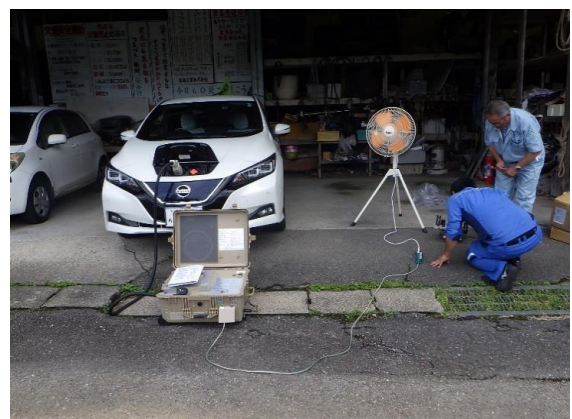
パワームーバーに送風機を接続して実際に動かしているところ
