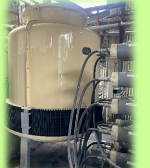
クーリングタワー入替（老朽化）
