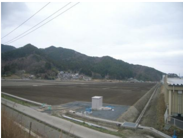
復興基盤総合整備事業下野地区工事 (上関伊郡大槌町)
