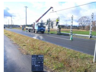
防雪柵の設置上げ下ろし
