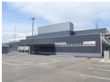
花巻ターミナル旅客増築工事（岩手県花巻市）
