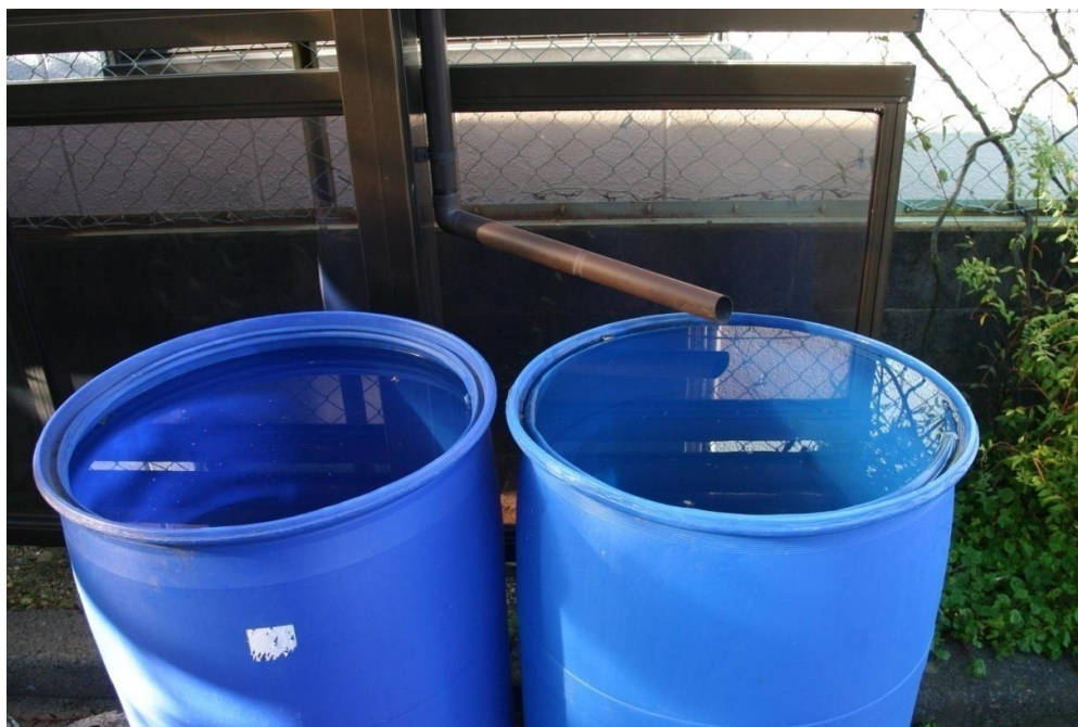
雨水を回収し再利用
