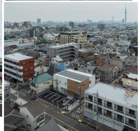
屋上太陽光パネル設置
