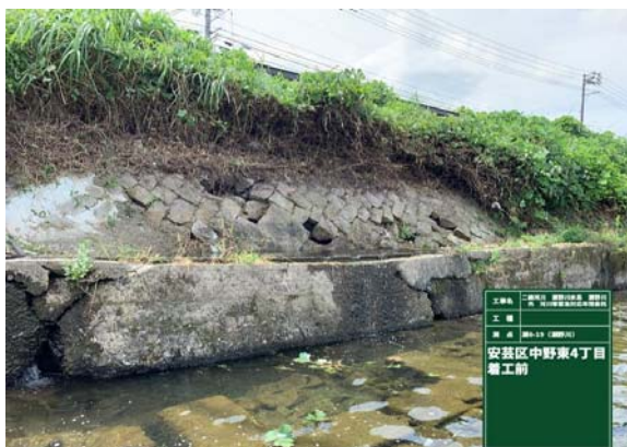
護岸補修(瀬野川左岸の護岸補修により、自治体の安全確保に寄与した。)
