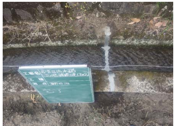
水路目地補修(安芸用水路の補修工事により、田畑への安定した水供給に寄与した。)
