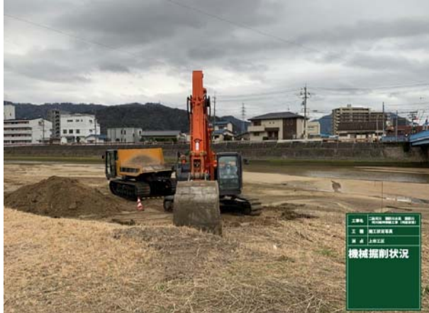
河床土の浚渫工事時、地元の「とんど」関係の要望に応じて河床土の温存をした施工を実施した。
