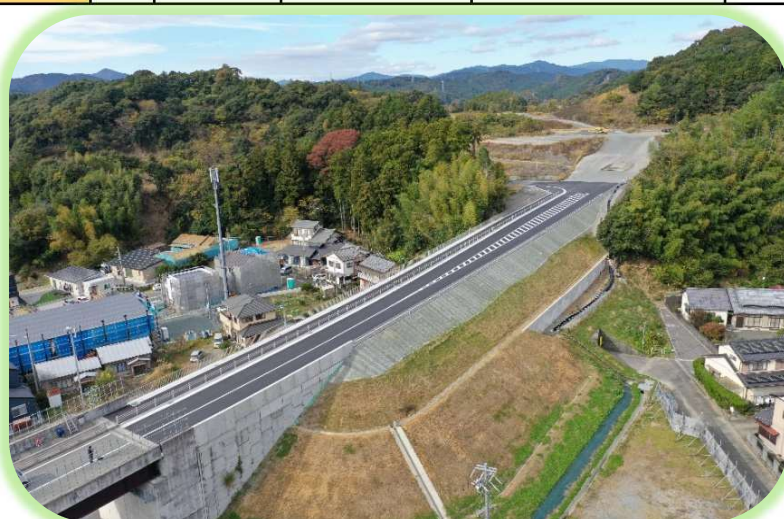
ICTを活用した工事の実施
