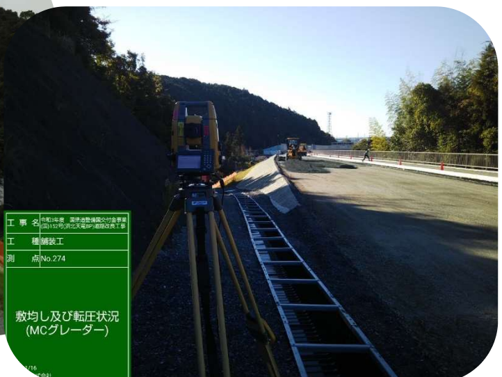
舗装工事にもICT施工導入
