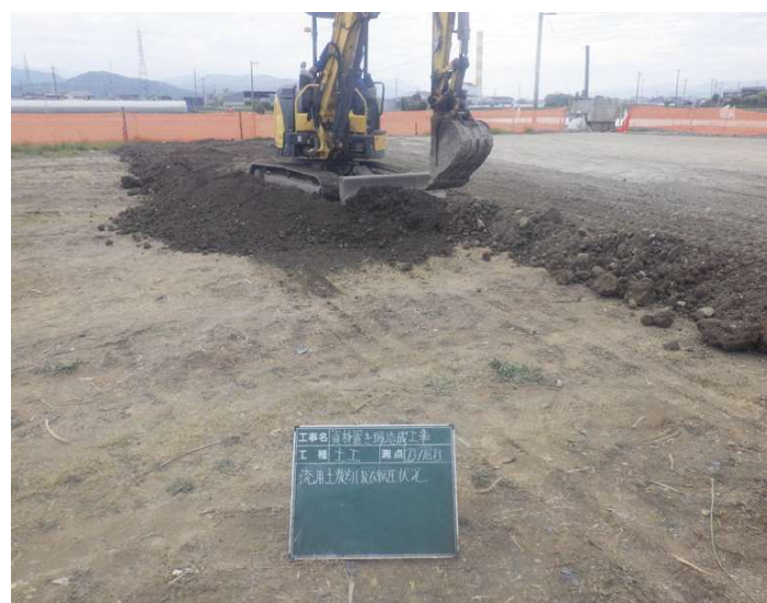
●流用土敷均しの様子
