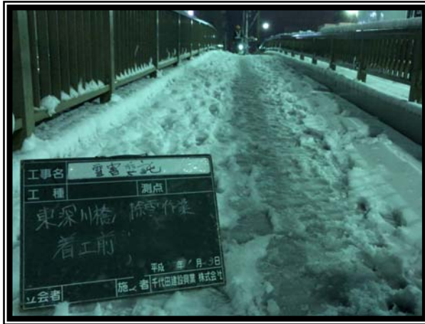
東深川橋（江東区内） 除雪作業前
