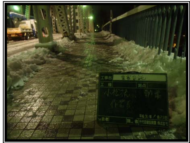
小松橋（江東区内） 除雪作業完了
