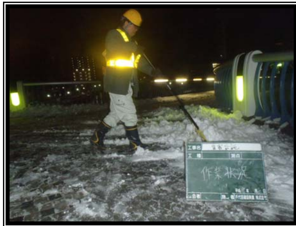
除雪作業状況 (江東区内)
