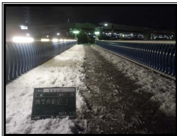
小名木川クローバー橋 (江東区内) 除雪作業完了
