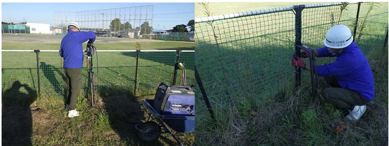
地域貢献（御前崎市牧之原市学校組合立御前崎中学校）作業日：R6年11月22日 作業内容：ソフトボール場外野フェンス修繕
