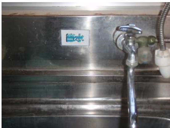
事務所給湯室 節水シール
