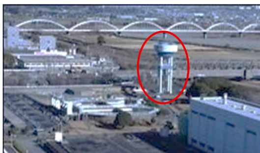
高さ約30mの高架水槽の塗装替え
