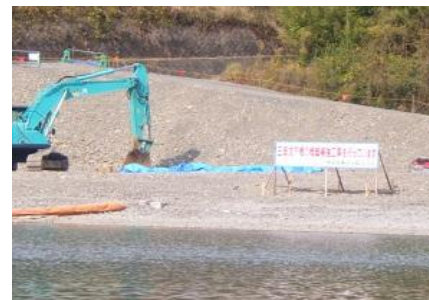
工事案内看板 の設
